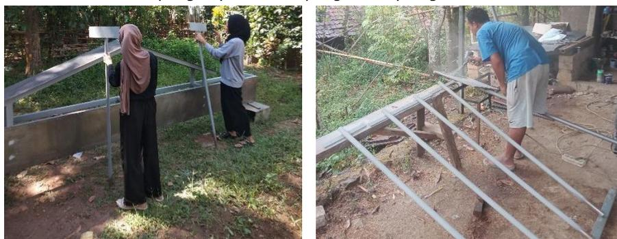
Gambar 5. Menunjukkan proses pengamplasan sebelum pengecatan plang dengan warna biru. Warna biru dipilih karena melambangkan kepercayaan diri serta warna biru merupakan warna yang jelas dilihat.
