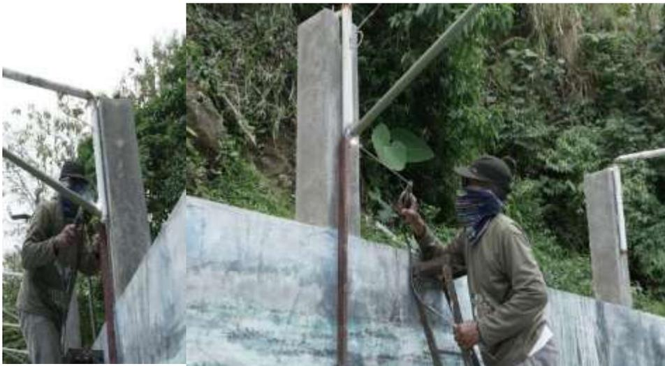
**Gambar 3.3:** Pemasangan atap seng pada pinggir kolam
